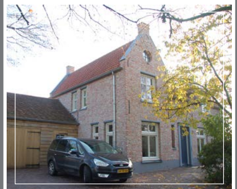
Nieuwbouw woning, Limmen
