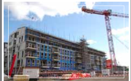
Appartementencomplex Het Brughuis plan Schelphoek, Alkmaar
