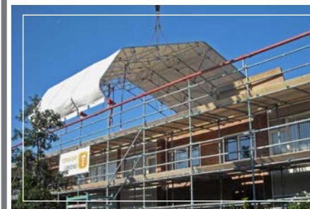
Renovatie woningen Duinwijk, IJmuiden
