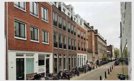
Nieuwbouw appartementen en renovatie school Elandshof, Amsterdam
