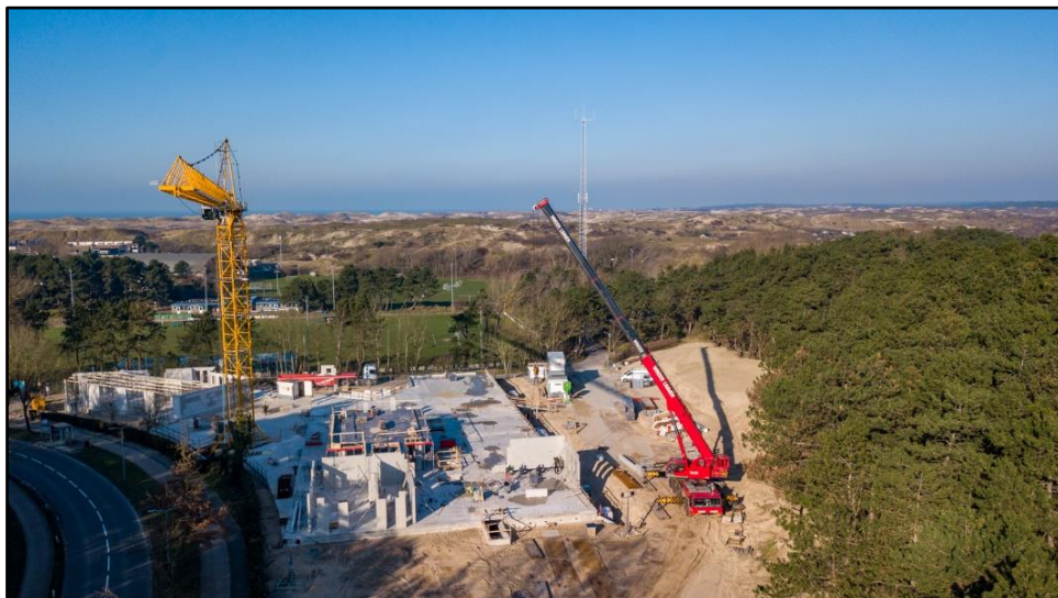
Het zorghotel en hospice (links achter) in aanbouw
