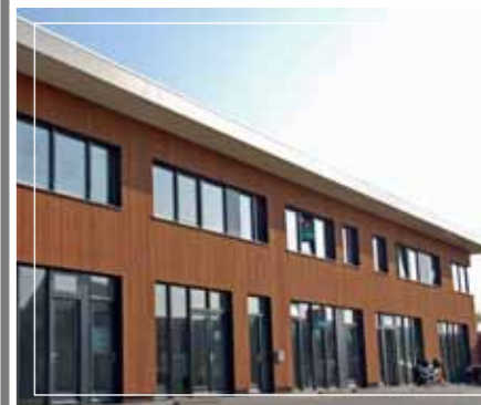
Ecoproject bedrijfsunits De Weidjes, Egmond aan den Hoef
