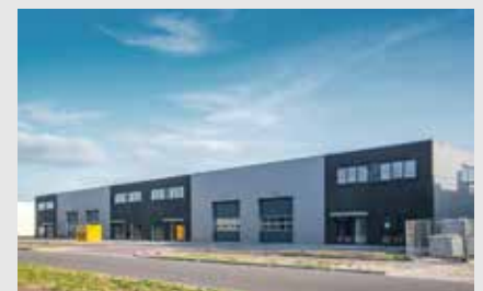
Van Velzen: Nieuwbouw Van Velzen Storage, Heiloo
