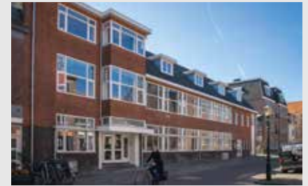
Breedstraat: Transformatie winkelpand/pop-podium tot appartementen, Alkmaar
